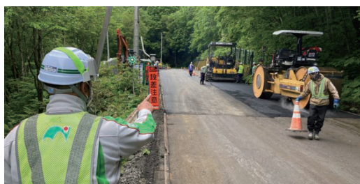
現場における作業状況の確認
