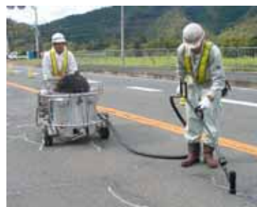
クラックシールNXの注入状況
