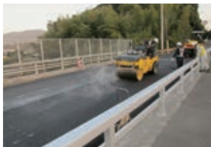
低温期でも丁寧な転圧作業が可能
