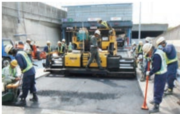
都市高速道路での施工状況
