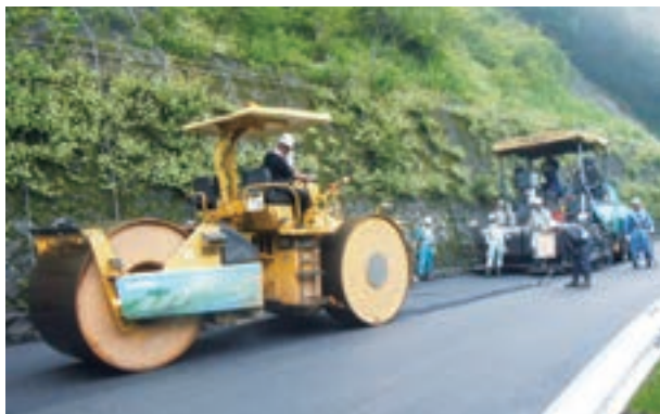
いろは坂での施工状況
