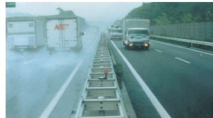
右/改質アスファルトによる排水性舗装が施工された道路(右)と一般舗装の道路(左)。一見してわかるほど、排水性の違いは歴然としている
