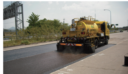
左/アスファルト乳剤の散布の状況
