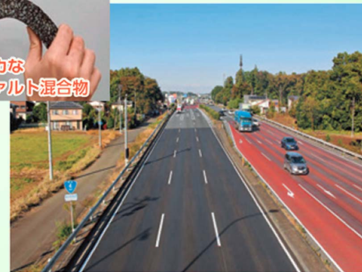
栃木県 国道4号バイパス
