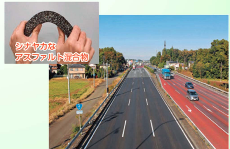
栃木県 国道4号バイパス
