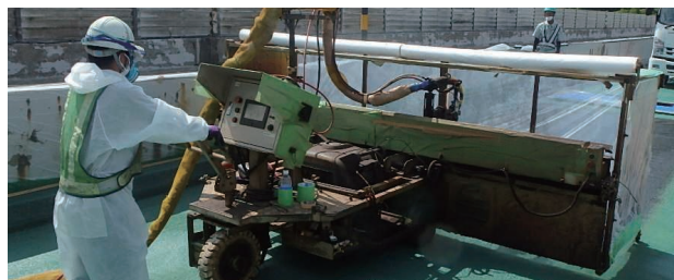
HQハイブレンAU工法(バインダー散布ロボットによる施工状況) 耐用年数30年を想定した耐久性の高いアスファルトウレタン塗膜系橋梁床版防水工法
