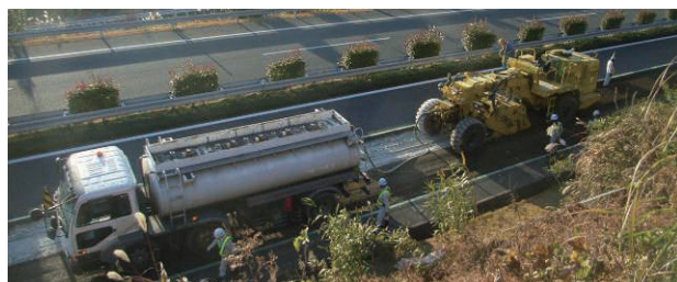
スタビセメントRC工法(ディープスタビライザーによる混合状況) 路上のアスファルト混合物と路盤を破碎し、同時にアスファルト乳剤およびセメントを混合するセメント・瀝青安定処理路盤工法(路上路盤再生工法)
