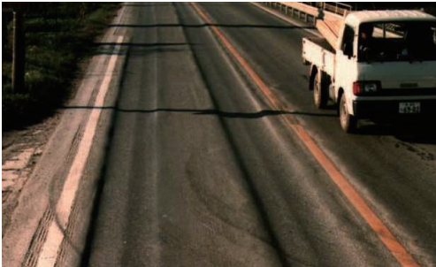
モータリゼーションの進展により生じたわだち掘れ対策に「ポリファルトSS」を使用
