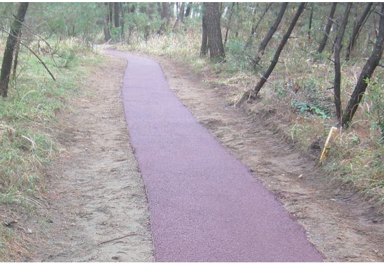
アスウッド舗装(ウッドチップ舗装)
