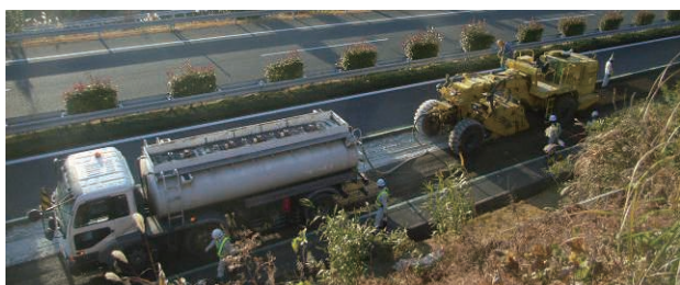
スタビセメントRC工法(ディープスタビライザーによる混合状況) 路上のアスファルト混合物と路盤を破砕し、同時にアスファルト乳剤およびセメントを混合するセメント・瀝青安定処理路盤工法(路上路盤再生工法)
