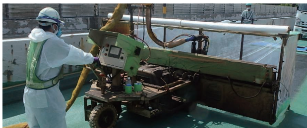
HQハイブレンAU工法(バインダー散布ロボットによる施工状況) 耐用年数30年を想定した耐久性の高いアスファルトウレタン塗膜系橋床版防水工法
