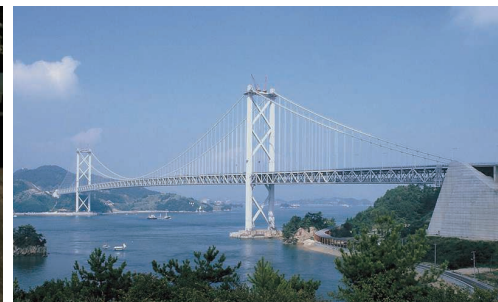
「シノファルト」が使用された本州四国連絡橋
