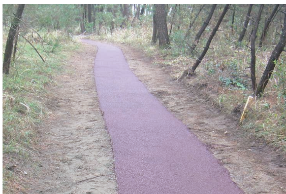
アスウッド舗装(ウッドチップ舗装)
