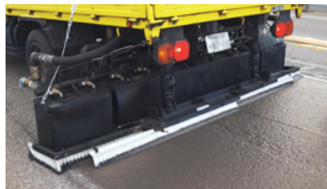
専用車両による敷き均し状況
