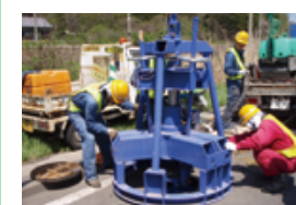
MR 2 工法 (マンホール上部補修工法)
