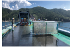
HQハイブレンAU工法 (高性能型橋梁床版防水工法)
