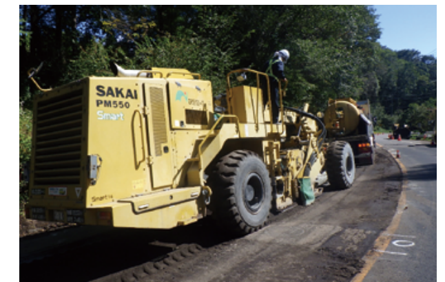
スタビセメントRC工法 (ロードスタビライザによる混合状況)
