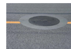
スーパーロメンパッチ (常温硬化型段差修正材)
