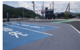
サーモテック工法 (遮熱性舗装)
