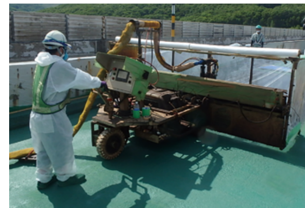
HQハイブレンAU工法 (バインダ散布ロボットによる施工状況)
