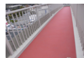
カラーファルトKT工法 (樹脂モルタルカラー舗装)
