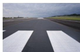
ポリファルトSS (耐流動・摩耗用改質アスファルト)
