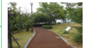
アスウッド舗装 (ウッドチップ舗装)
