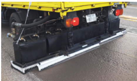
専用車両による敷き均し状況
