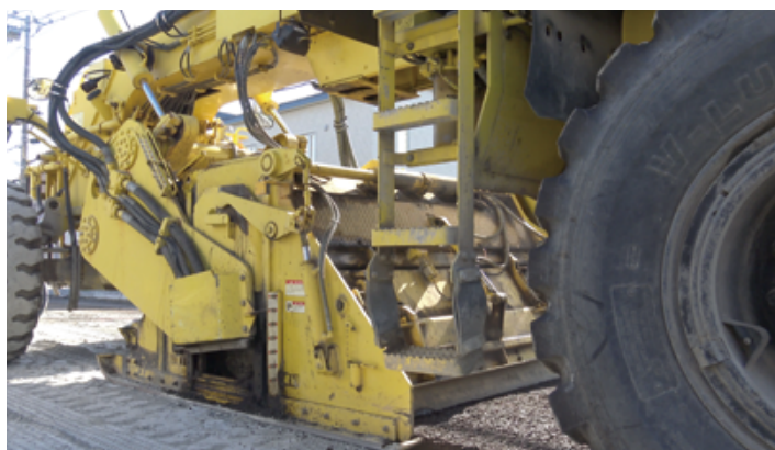
ロードスタビライザによる施工状況
