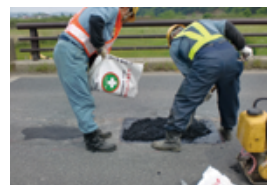
レスキューパッチ (高耐久・全天候型常温パッチング材)
