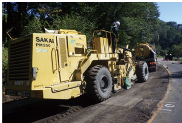
スタビセメントRC工法（ロードスタビライザによる混合状況）
