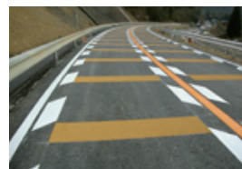
コールカットR工法 (樹脂系滑り止め舗装)
