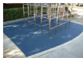
カラーファルトDA工法 (ゴムチップ舗装)
