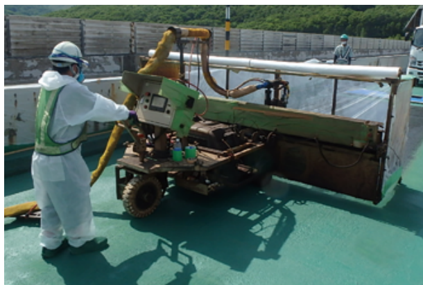
HQAハイプレAU工法（バインダ散布ロボットによる施工状況）
