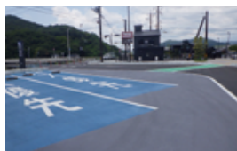
サーモテック工法 (遮熱性舗装)
