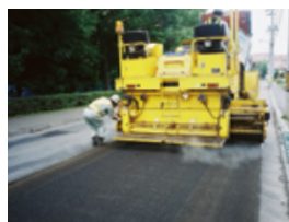
4 ひび割れの発生を遅延させる「エマルテックSAMI工法」
