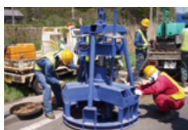
MR 2 工法 (マンホール上部補修工法)
