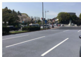
サーモテック工法 (遮熱性舗装)
