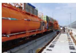
CAモルタル充填工法 (新幹線スラブ軌道充填工法)
