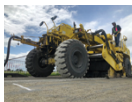
6 ICT技術を活用したロードスタビライザによる「スタビセメントRC工法」
