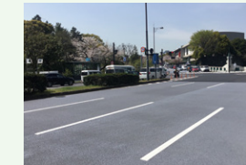
サーモテック工法 (遮熱性舗装)
