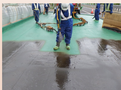
高性能型橋梁床版防水工法 「HQハイブレンAU工法」
