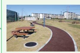
アスウッド舗装 (ウッドチップ舗装)
