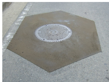
施工後の状況
