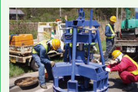
MR²工法 (マンホール上部補修工法)
