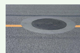
スーパーロメンパッチ (常温硬化型段差修正材)
