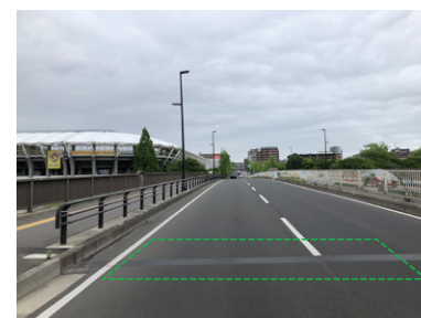
施工後の状況
