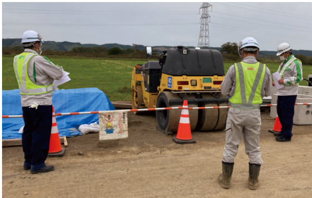
現場における安全パトロール
