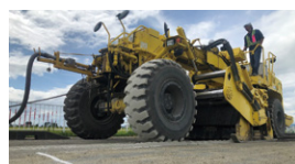
ロードスタビライザによる施工状況
