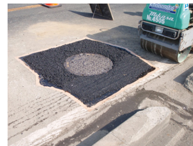
施工後の状況
