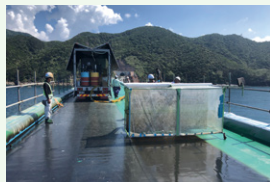
HQハイブレンAU工法 (高性能橋梁床版防水工法)
