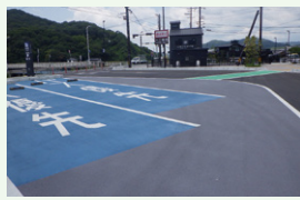
サーモテック工法 (遮熱性舗装)
