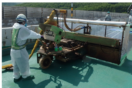
バインダ散布ロボットを活用したHQハイプレAU工法
