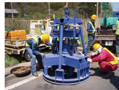
施工状況（マンホールの撤去）
