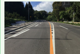
シナヤカファルト (長寿命化舗装用改質アスファルト)
