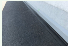
ピタッとし型止水テープ (橋梁端部用成型止水材)
