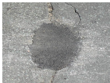
施工後の状況
