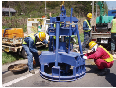
施工状況（マンホールの撤去）
