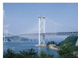
③ 長大橋(本州四国連絡橋)に 使用された「シノファルト」
