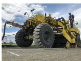
⑥ ICT技術を活用したロードスタビライザによる「スタビセメントRC工法」
