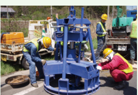
MR 2 工法 (マンホール上部補修工法)
