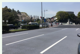
サーモテック工法 (遮熱性舗装)
