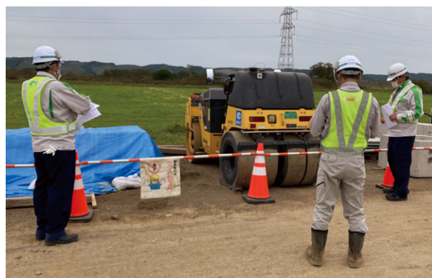
現場における安全パトロール
