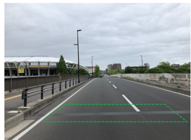
施工後の状況
