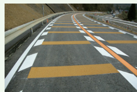
コールカットR工法 (樹脂系滑り止め舗装)
