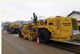
スタビセメントRC工法 (路上路盤再生工法)
