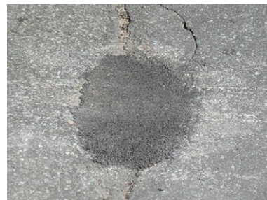
施工後の状況
