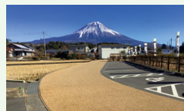
カラーファルトTO工法 (自然石舗装)
