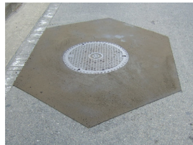
施工後の状況
