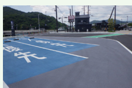
サーモテック工法 (遮熱性舗装)
