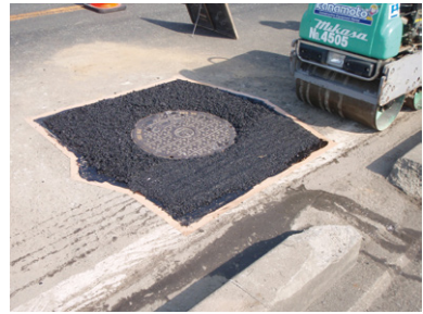
施工後の状況
