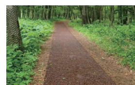
アスウッド舗装
