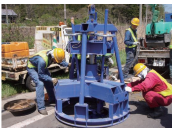
施工状況(マンホールの撤去)
