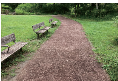
ナラ枯れ被害木を用いた アスウッド舗装
