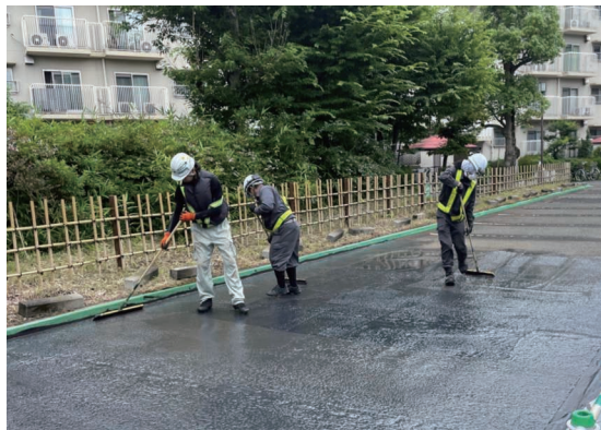
人力による施工状況
