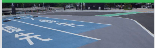
サーモテック工法 (遮熱性舗装)
