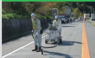
クラックシールNX (加熱注入型ひび割れシール材)
