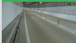
カラーファルトクリア (明色舗装)
