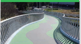
カラーファルトKT工法 (樹脂モルタルカラー舗装)
