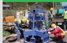
MR 2 工法 (マンホール上部補修工法)
