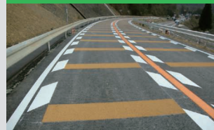
コールカットR工法 (樹脂系滑り止め舗装)
