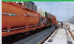
CAモルタル充填工法 (新幹線スラブ軌道充填工法)
