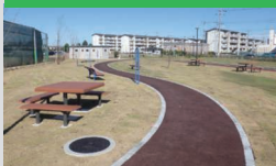
アスウッド舗装 (ウッドチップ舗装)
