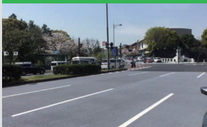
サーモテック工法 (遮熱性舗装)
