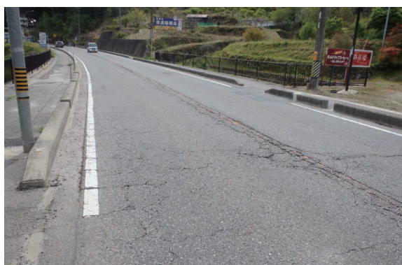
破損が進行した既設舗装
