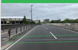
シームレスジョイント (埋設型伸縮装置)
