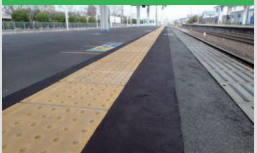
スーパーロメンパッチ (常温硬化型段差修正材)
