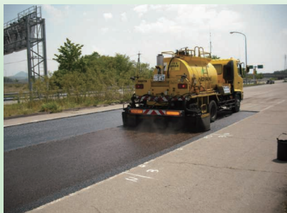
速分解型アスファルト乳剤 「スーパータックゾール」
