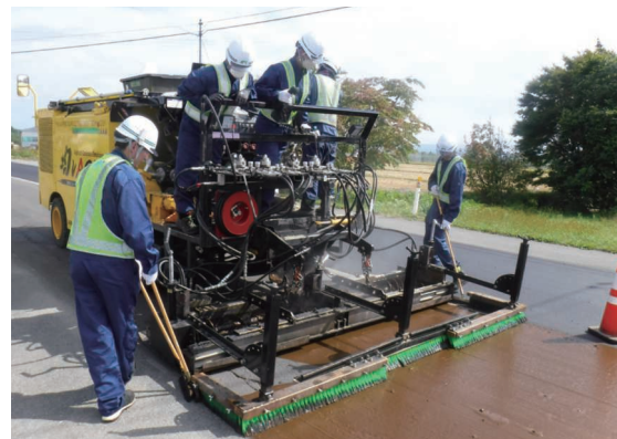
専用車両による敷き均し状況
