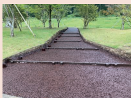
5 間伐材を燃やさずにリサイクルできる「アスウッド舗装」
