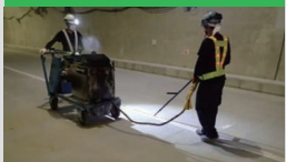
セロシール (コンクリート目地用加熱注入材)
