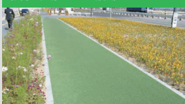
コールカットR工法 (樹脂系滑り止め舗装)
