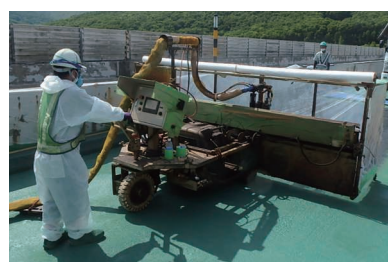
パインダ散布ロボットを活用したHQハイブレンAU工法
