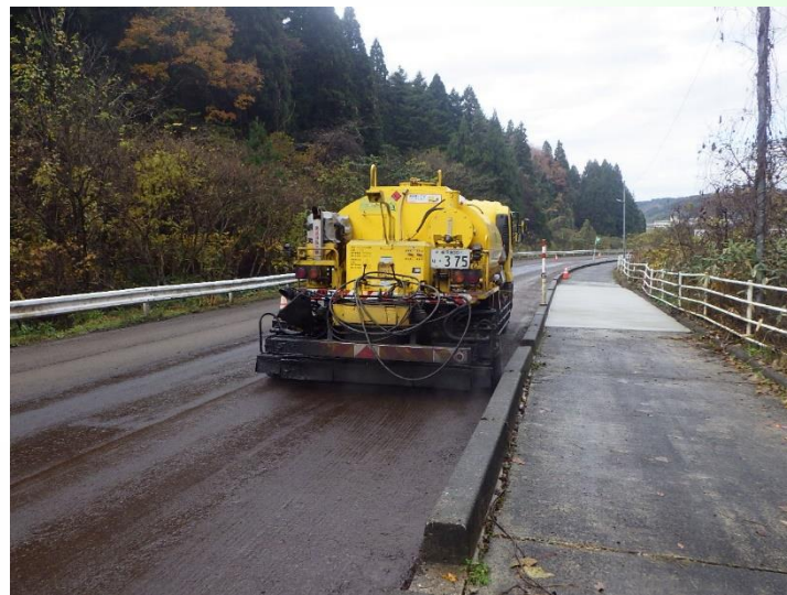
デストリビュータによるアスファルト乳剤散布
