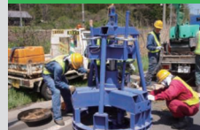
MR 2 工法 (マンホール上部補修工法)
