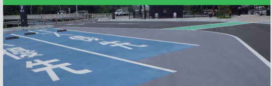
サーモテック工法 (遮熱性舗装)
