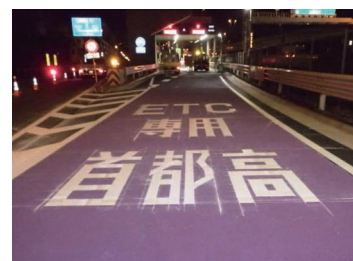
首都高速道路のETC専用レーン標示
