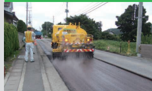
スーパータックゾール (速分解型アスファルト乳剤)
