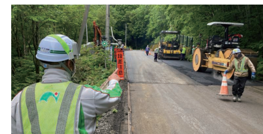
現場における作業状況の確認
