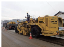
⑥ ICTを活用したロードスタビライザによる「スタビセメントRC工法」
