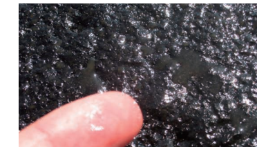
路面温度5℃で散布から1分後の状況
