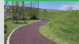
アスウッド舗装 (ウッドチップ舗装)
