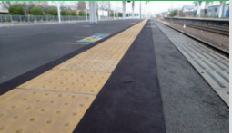
スーパーロメンパッチ (常温硬化型段差修正材)
