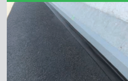
ピタッとし型止水テープ (橋梁端部用成型止水材)
