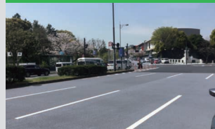
サーモテック工法 (遮熱性舗装)
