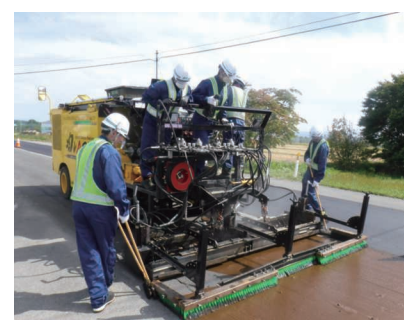
専用車両による敷き均し状況
