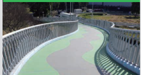
カラーファルトKT工法 (樹脂モルタルカラー舗装)
