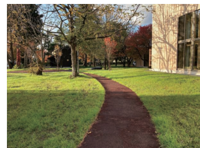
ウッドチップ舗装 「アスウッド舗装」
