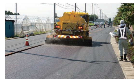
専用車両による散布状況
