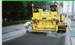
エマルテックSAMI工法 (ひび割れ抑制じょく層工法)
