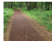
アスウッド舗装
