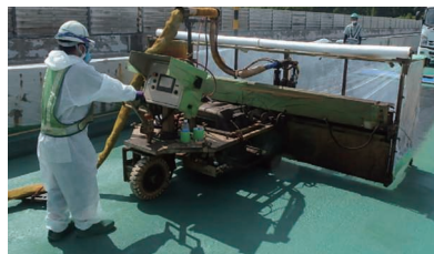
パインダ散布ロボットを活用したHQPハイプレッシャー工法
