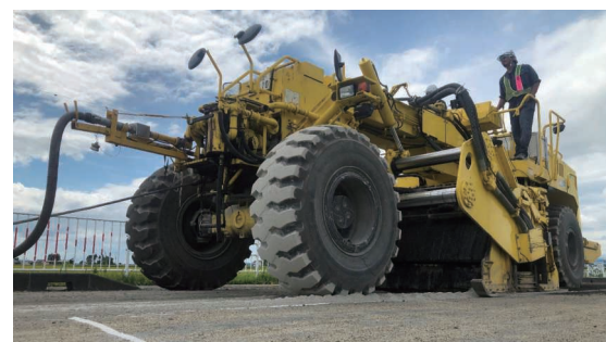
施工状況 液状化に対する抵抗性試験
