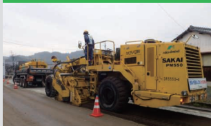
スタビセメントRC工法 (路上路盤再生工法)
