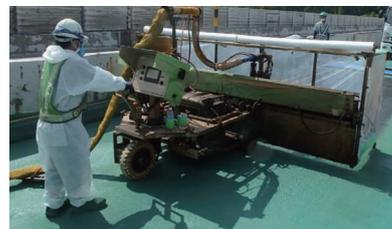
パインダ散布ロボットを活用したHQハイプレソウ工法
