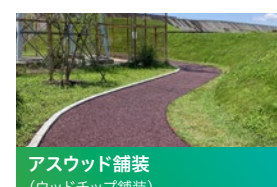
アスウッド舗装 (ウッドチップ舗装)
