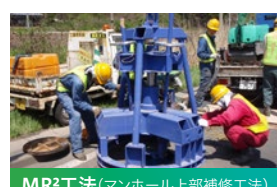
MR 2 工法 (マンホール上部補修工法)
