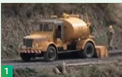
1 路上混合式工法で砂利道を舗装に変える「カチオゾール」
