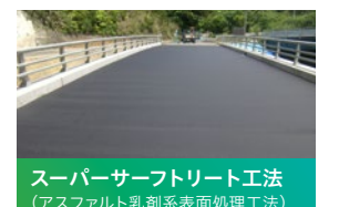
スーパーサフトリート工法 (アスファルト乳剤系表面処理工法)
