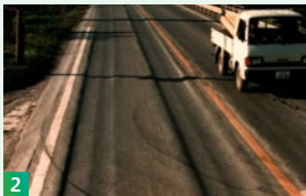
2 モータリゼーションの進展により生じたわだち掘れの対策に「ポリファルト SS」
