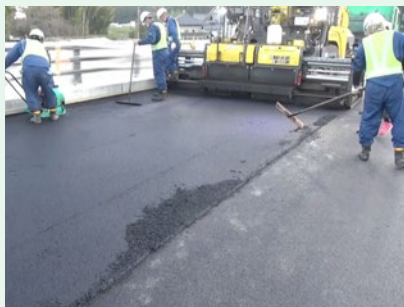
高耐久型床版防水・舗装一体型工法 「HQペーパーレン工法」
