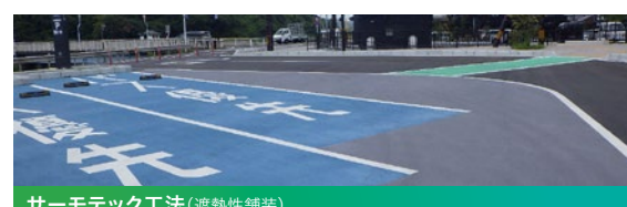
サーモテック工法 (遮熱性舗装)
