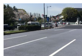
サーモテック工法 (遮熱性舗装)
