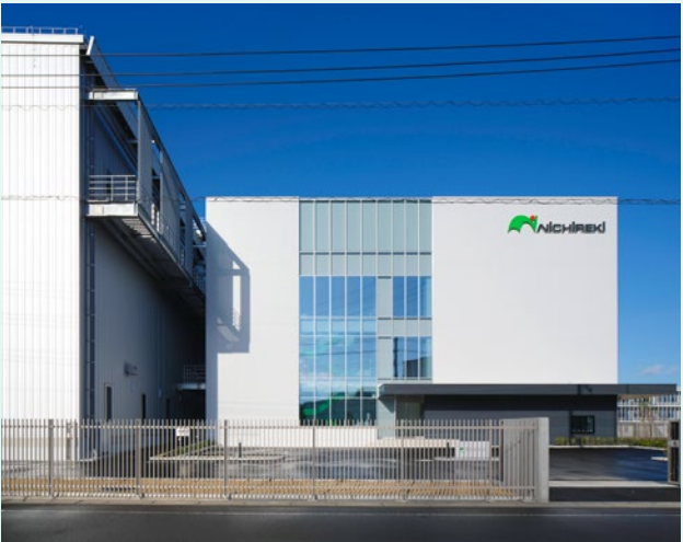
3 総合テクニカルセンター棟
