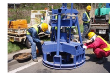
施工状況（マンホールフレームの撤去）
