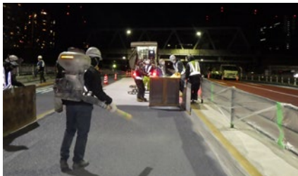
遮熱性舗装の施工
