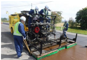
専用車両による敷き均し状況
