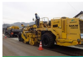
スタビセメントRC工法 (路上路盤再生工法)
