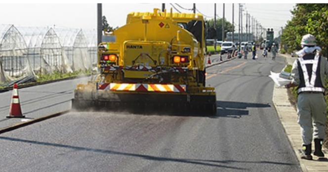
専用車両による散布状況
