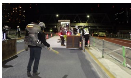
遮熱性舗装の施工
