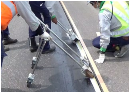
専用機材による施工
