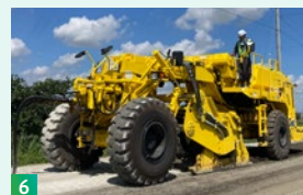
6 ICTを活用したロードスタビライザによる「スタビセメントRC工法」
