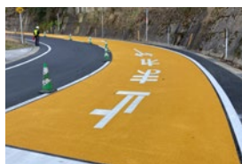
コールドカットR工法 (樹脂系滑り止め舗装)
