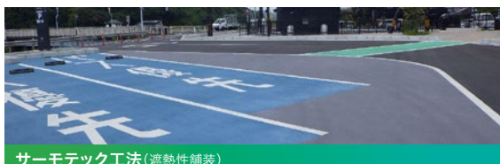
サーモテック工法 (遮熱性舗装)
