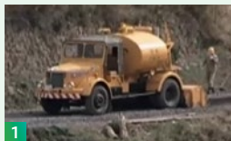
路上混合式工法で砂利道を舗装に変える「カチオゾール」
