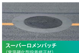
MR 2 工法 (マンホール上部補修工法)
