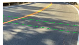
HQシームレスジョイント工法 (道路橋用埋設型伸縮継手装置)
