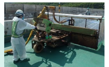
バインダ散布ロボットを活用したHQ/ハイブレンAU工法
