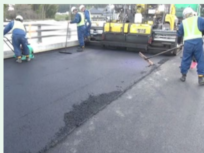
高耐久型床版防水・舗装一体型工法 「HQペープレン工法」
