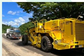
ICTを活用したスタビセメントRC工法
