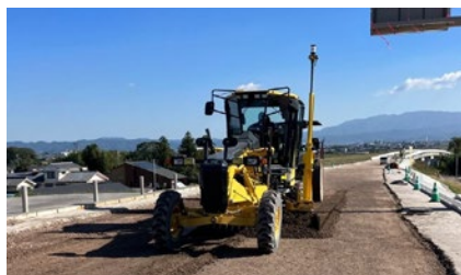
マシンコントロール仕様のモーターグレーダー
