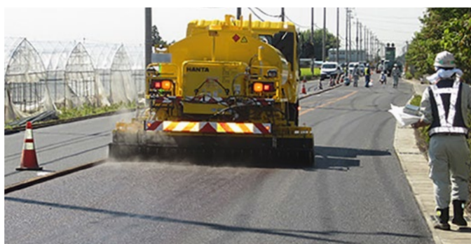
専用車両による散布状況
