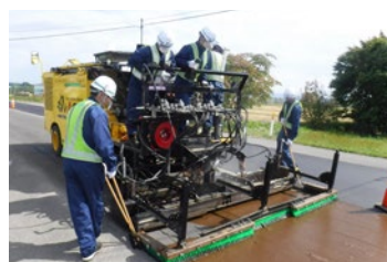
専用車両による敷き均し状況
